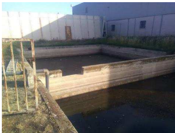
Figure 3 : Bassin lixiviats de la plateforme de compostage.
