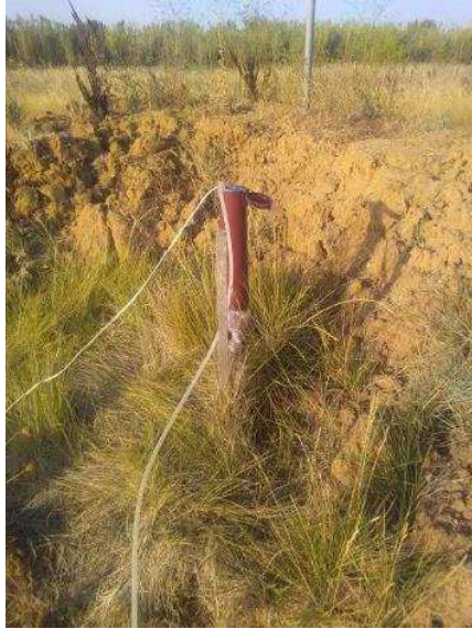
Piézomètre SC3 (position aval)
